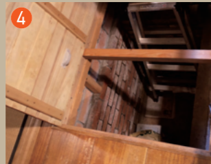
床は桐の板。一部が戸になっていて開けると床下に煉瓦積のムロ。
