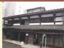
改修現場見学会 (川縁米穀店)
