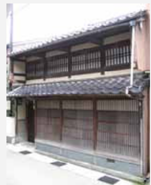
江戸時代に建てられた町家 伝統的意匠をよく残している
