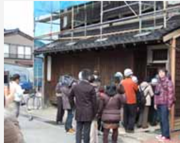
改修中の千日町の町家
