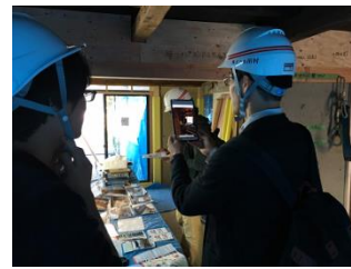
10/14 ゲストハウス改修現場見学
