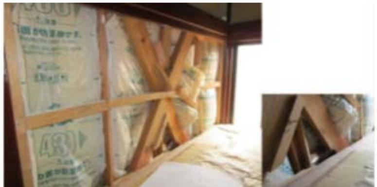
\*3:垂直材（柱、土台）と水平材（梁、桁）で構成される四角形のフレームに、地震による水平力に耐えて変形しないように入れる斜め材である。建築基準法では筋かいを入れ、筋かいとフレームの接合部を金物で補強することが求められている。
